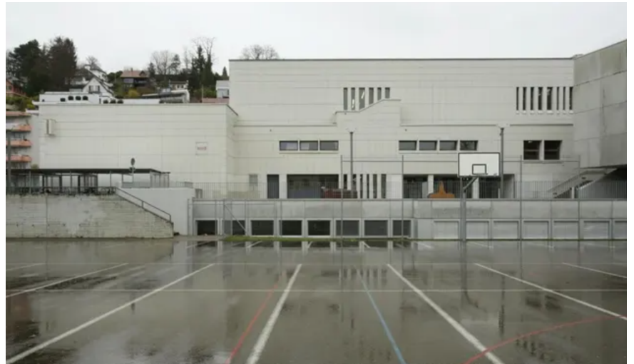
Abb. 1 Turnhalle bestehend, Quelle: Zürichsee-Zeitung
