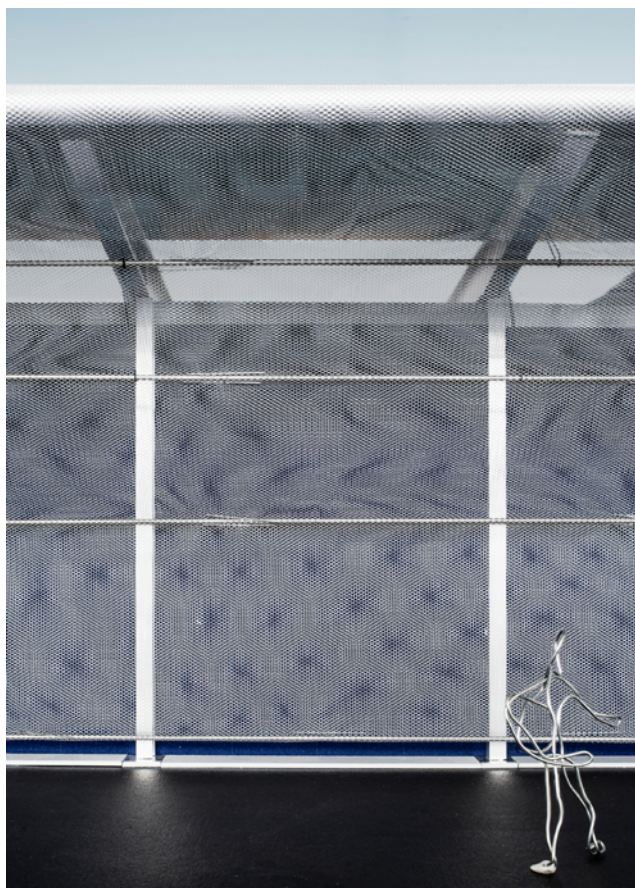
Blick auf die Fassade
